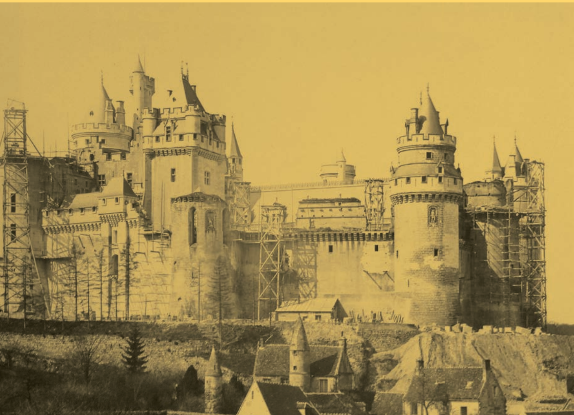
Vue du château de Pierrefonds depuis l'angle nord-est, s. d., Charenton-le-Pont, Médiathèque de l'architecture et du patrimoine, Fonds ancien, MH 14160.
