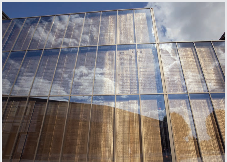
▼ Sophie Mallebranche, matière dorée n°31_OW habillant la façade de « La Passerelle », médiathèque de Trévoux, choisie pour rendre hommage au passé de tréfilerie de la ville ; architectes : Vurpas et Associés (p. 41).
