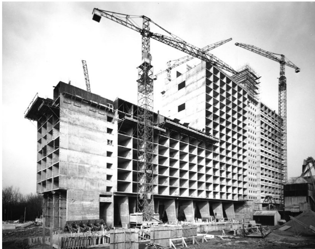
79 Jean-Pierre Bourraux, L'Unité d'habitation de Briey-en-Forêt en construction , 1959
